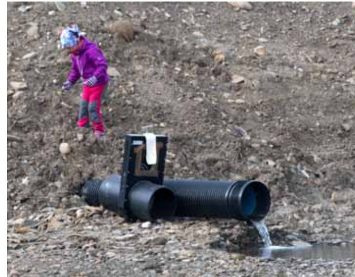
Etter at det ble montert ventiler på plastrørene som fører vann inn i Laguna forsommeren 2017, er det mulig å regulere hvor mye vann som renner inn.
