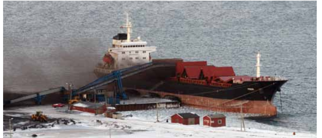
Det er helårlig lasting av kullskip ved Kullkaia. På bildet lastes «Pride». Normalt er det en trekk ut fjorden og kullstøv blåser da mot Longyearbyen Camping, noe som er godt synlig i landskapet.
