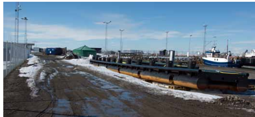
Grusveien medfører at det blir bløtt om våren når tela går og ved regnvær. Bør asfalteres.
