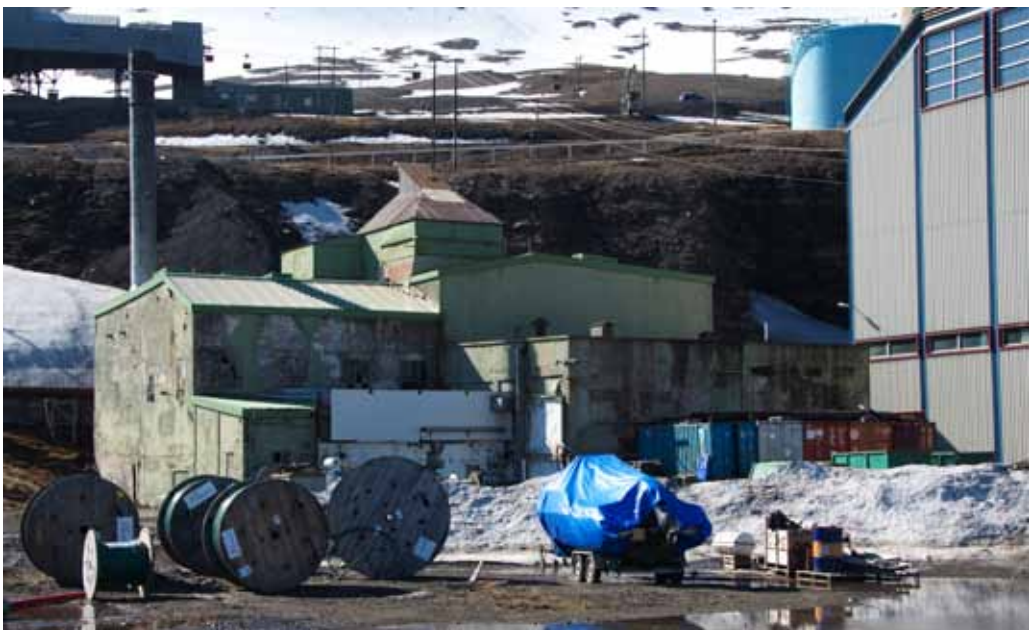
I 1920 bygde Stor Norske Spitsbergen Kulkompani en ny kraftstasjon i betong med rom til dampkjele, sal med to turbiner og sjøvanninntak. Dette er den grønne murbygningen som står ved siden av dagens energiverk.
