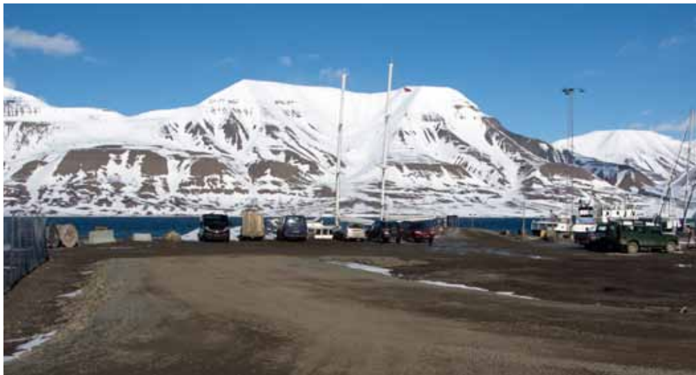
Parkeringa til flytebryggene er gruslagt. Sølete om våren og ved regn. Området skal asfalteres august 2017.
