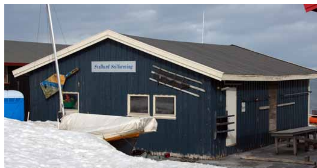
Huset til Svalbard seilforening i Sjøområdet.
