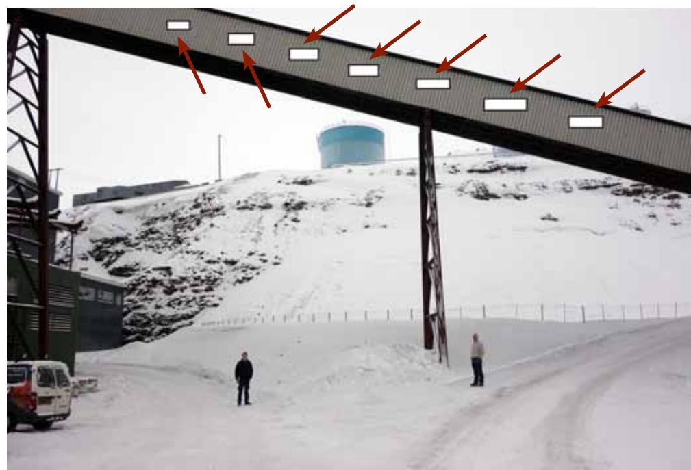
Teistkasser kan settes opp på bygninger nær sjøen i Longyearbyen, for eksempel på tilførselskanalen for kull på Energiverket.
