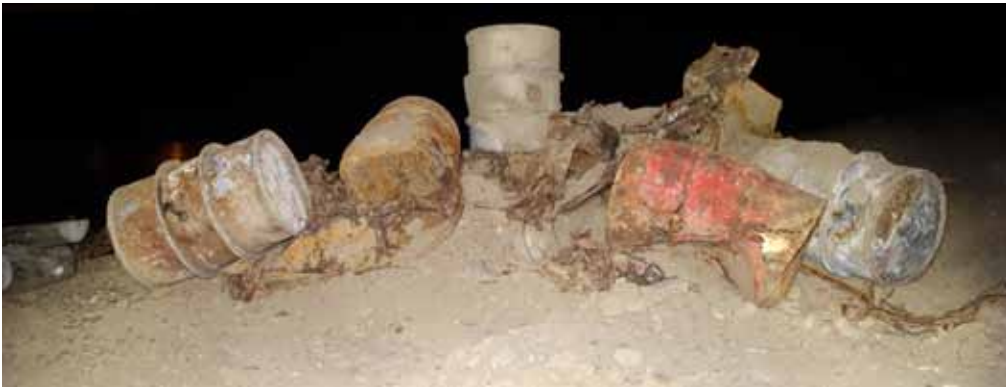
Under gravearbeidet med å legge plastrør for å lede vann fra Flyplassbekken inn i Laguna, ble det svært overraskende funnet masse jernskrap under gravearbeidene. Et bilvrak medførte at traséen for plastrørene måtte justeres. Ti gamle oljefat ble levert til avfallsanlegget.
