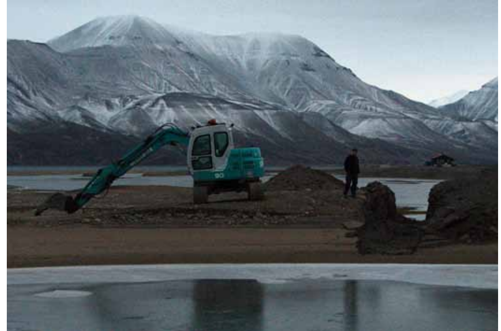
I 2016 ga LL tillatelse til å ta vann fra Flyplassbekken og lede inn i Laguna. Svalbards miljøvernfond ga støtte til tiltaket, og gravearbeider startet sent på høsten. Plastrør ble lagt for å lede vannet.
