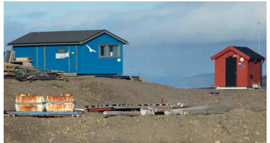
Adventdeltaet beskrives med plakater på og inne i LoFFhuset, samt på Pumpehuset ved siden av.
