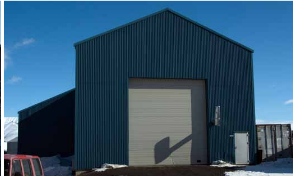
På venstre siden ligger en stor hall. Dette er Totakterens verksted.
