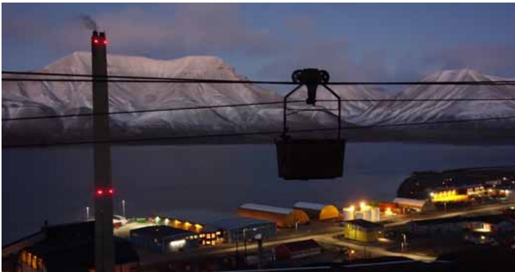
På wiren som går mellom taubanebukkene fra Taubanesentralen og vestover henger det kubb som kullet ble fraktet i.
