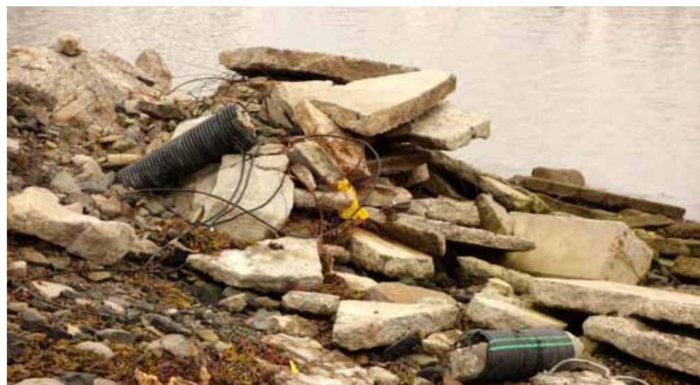
Knuste betongplater med armeringsjern, plastrør og ståltråd skjemmer fjæra. Må fjernes.
